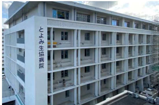
バイパス 北側より撮影
