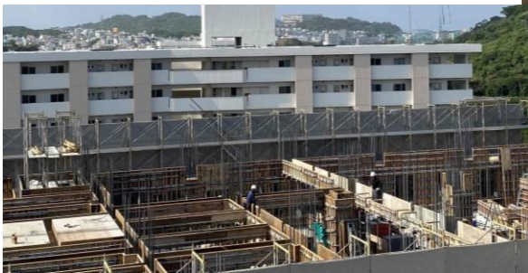
6階の工事をしています
