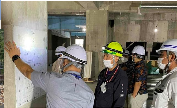
図面を確認しながらの現場視察
